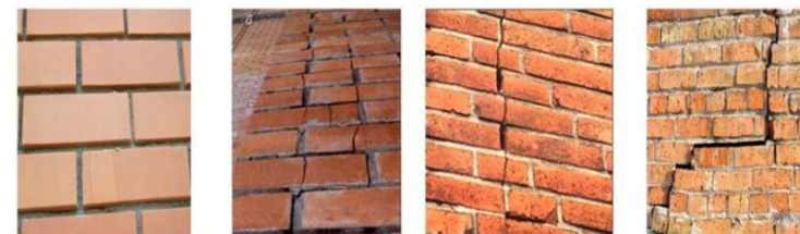
Рисунок 1. Трещины, возникающие в кирпичной кладке (1 – осадка грунта средней части здания, 2 – осадка грунта крайних частей здания, 3 – разлом здания вследствие максимальных осадок крайних частей здания и минимальной осадки в центральной части, 4 – просадка части здания, приводящей к образованию вертикальной извилистой трещины.)
